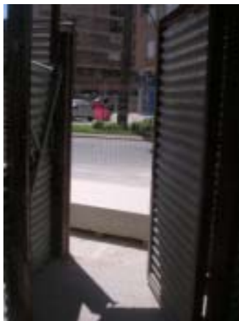
Salida de emergencia de la C/ E. Ferrer (si ante un incendio, bajas corriendo sin tropezar con nada, lo harás al llegar al final). Situación habitual.
